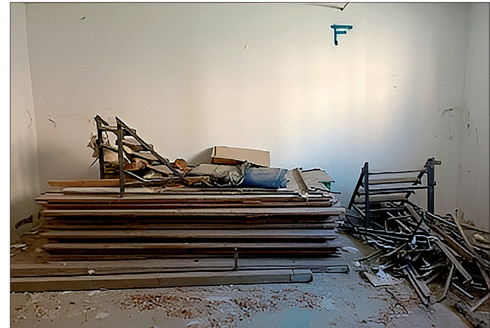
Fig. 4 - La stanza prima della ristrutturazione.
