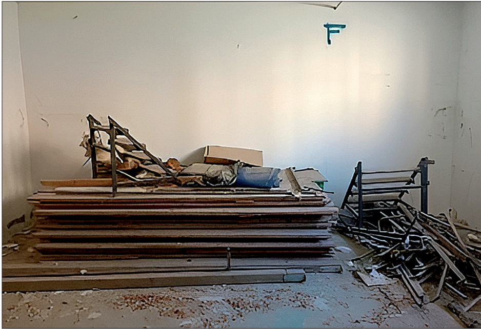
Fig. 4 - La stanza prima della ristrutturazione.
